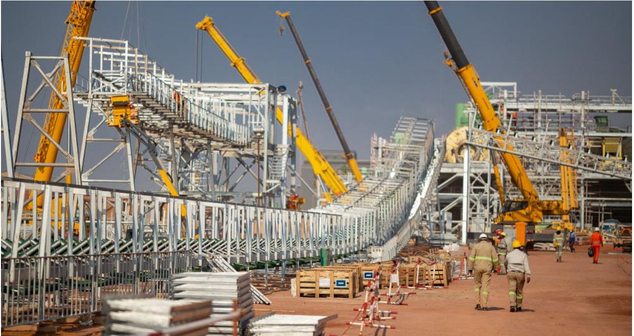
起重机在Ⅱ期选厂进行矿石传送机的分段吊装。
