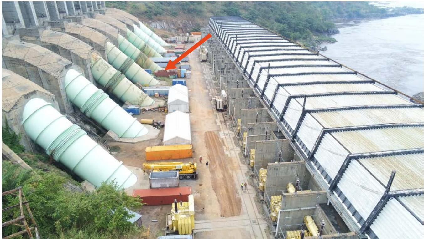
位于刚果河上的英加一期(后)和英加二期(前)水电站的鸟瞰图。红圈位置为英加二期 5 号涡轮机的压力管道。
