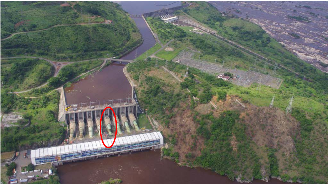
英加二期水电站的 5 号涡轮机组 (红圈显示其压力管道) 升级后, 将会产生额外的 162 兆瓦清洁电能。
