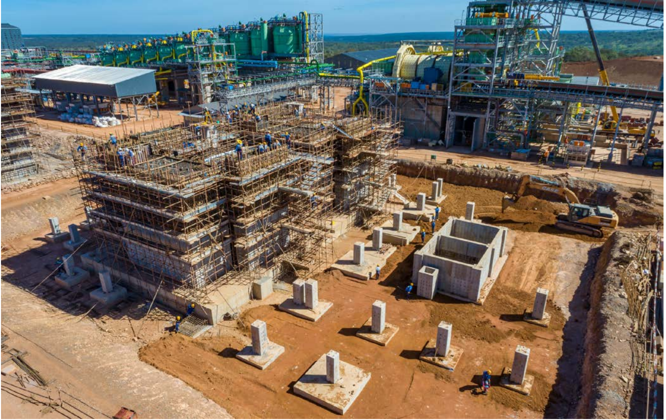
第二序列球磨机的地基工程。
