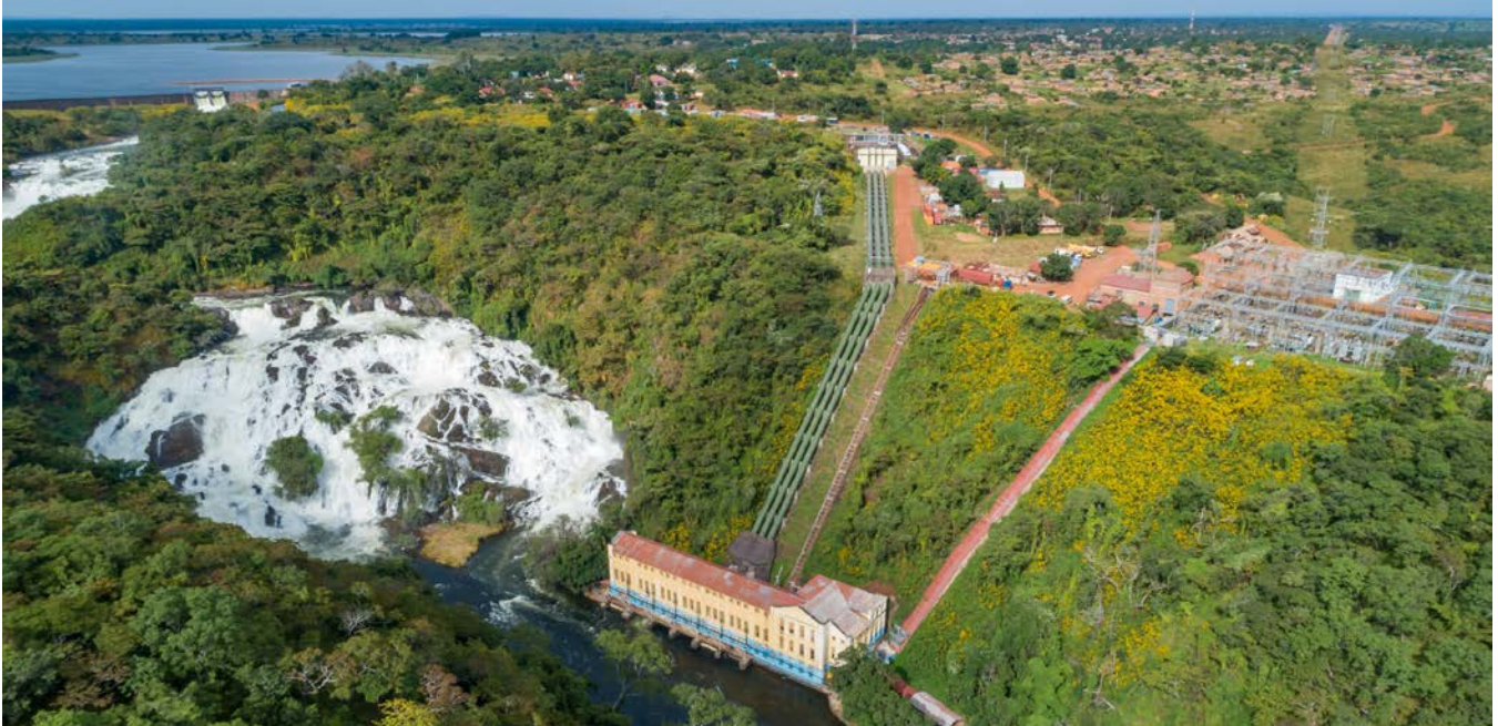
英加二期水电站的 5 号涡轮机组 (红圈显示其压力管道) 升级后, 将会产生额外的 162 兆瓦清洁电能。
