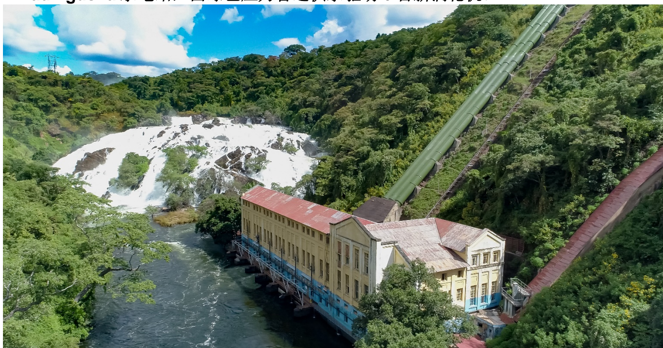
Mwadingusha 水电站，由绿色压力管道供水驱动 6 台新涡轮机。
