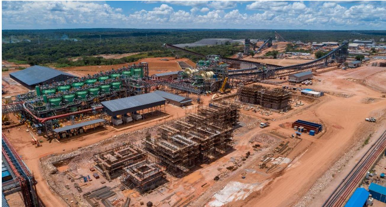
另一个视角显示卡莫阿-卡库拉铜矿Ⅰ期年处理 380 万吨矿石的选矿厂（红色圆圈内）即将完工，而第二座年处理 380 万吨矿石的选矿厂（Ⅱ期工程）土建工程正在快速推进。精矿仓（近前位置）的屋顶正在铺设中。
