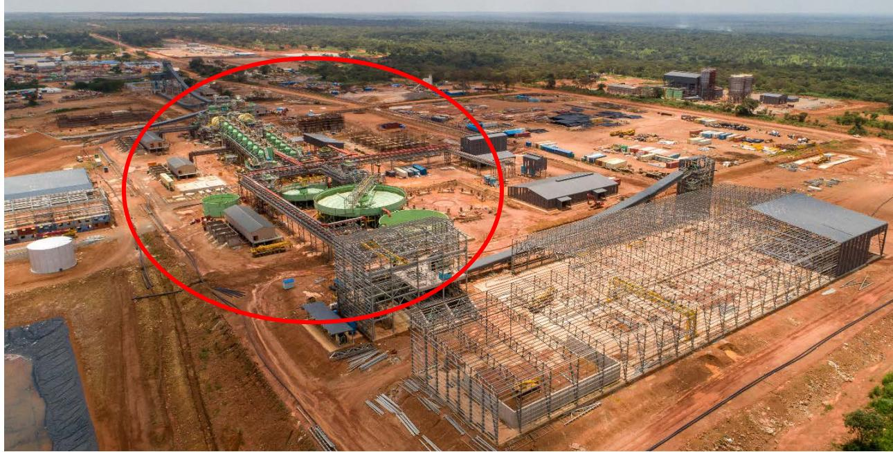
卡莫阿-卡库拉铜矿Ⅰ期选矿厂的球磨机（黄色）正在进行第二阶段试车（C2），此外，Ⅱ期选矿厂（前景）球磨机的混凝土地基正在浇筑中。
