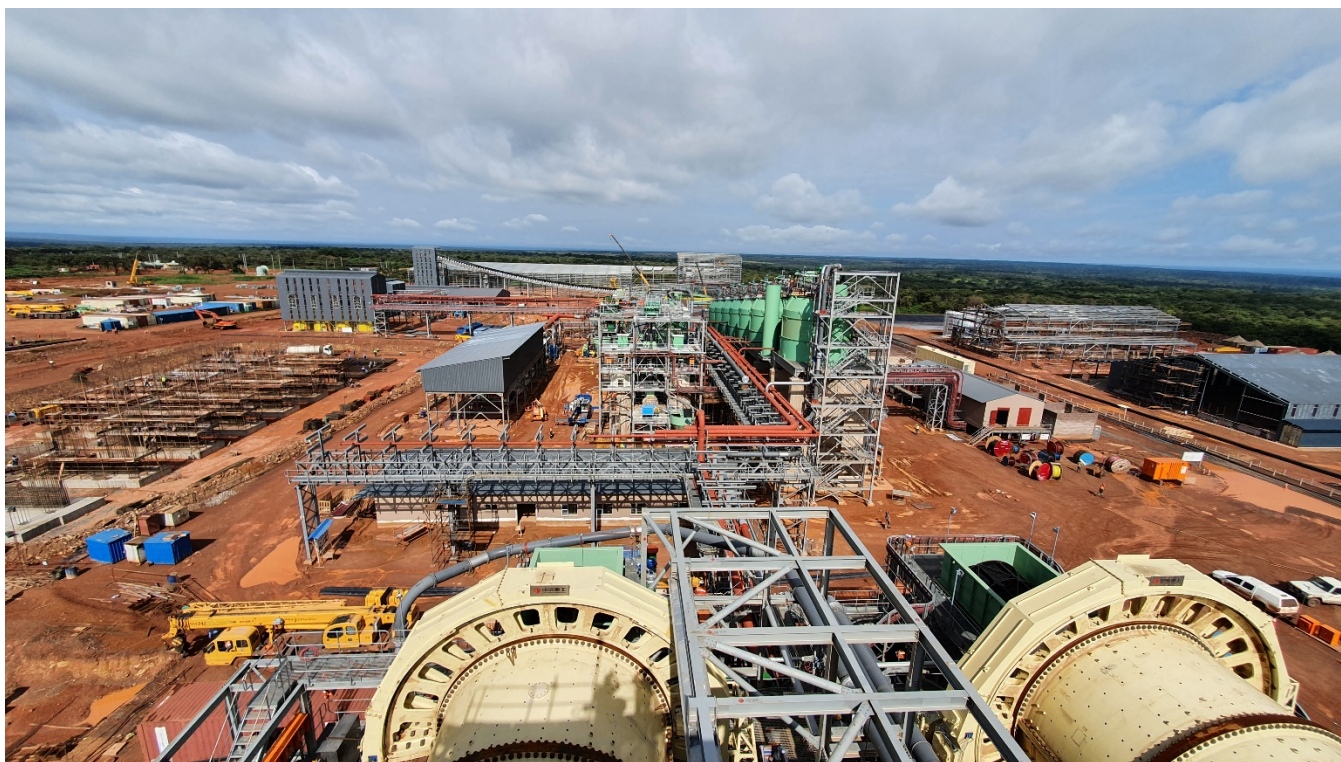
卡库拉第一期回填厂即将完工。矿山约一半的尾矿将被泵回地下，用于采空区的回填。
