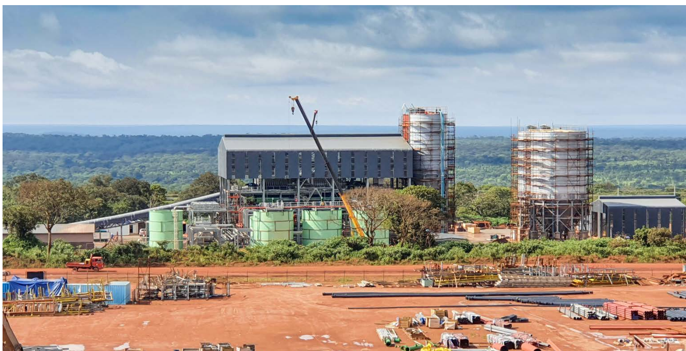
卡库拉第一期回填厂即将完工。矿山约一半的尾矿将被泵回地下，用于采空区的回填。
