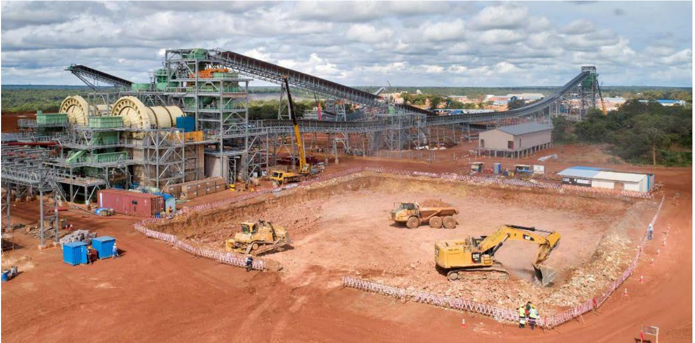
为第二座 380 万吨/年选矿厂的球磨机所在区域的地基浇筑混凝土。
