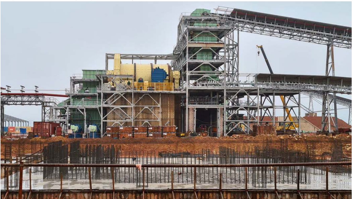
为第二座 380 万吨/年选矿厂的球磨机所在区域的地基浇筑混凝土。
