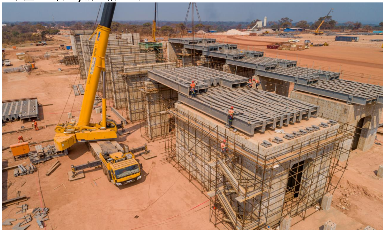
一台载重 400 吨 的起重机将浮选厂的钢结构工作台放置在卡库拉初始选矿厂 (年处理矿量 380 万吨 ) 的混凝土地基上。
