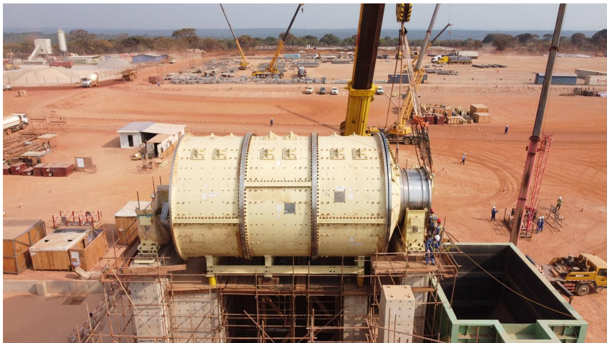
一台载重 400 吨 的起重机将浮选厂的钢结构工作台放置在卡库拉初始选矿厂 (年处理矿量 380 万吨 ) 的混凝土地基上。
