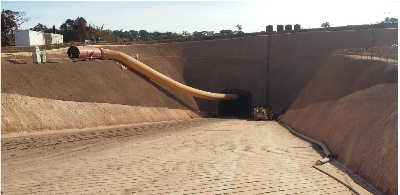
图 11 : Kakula 南面的箱形挖槽和斜坡道的入口位置。
