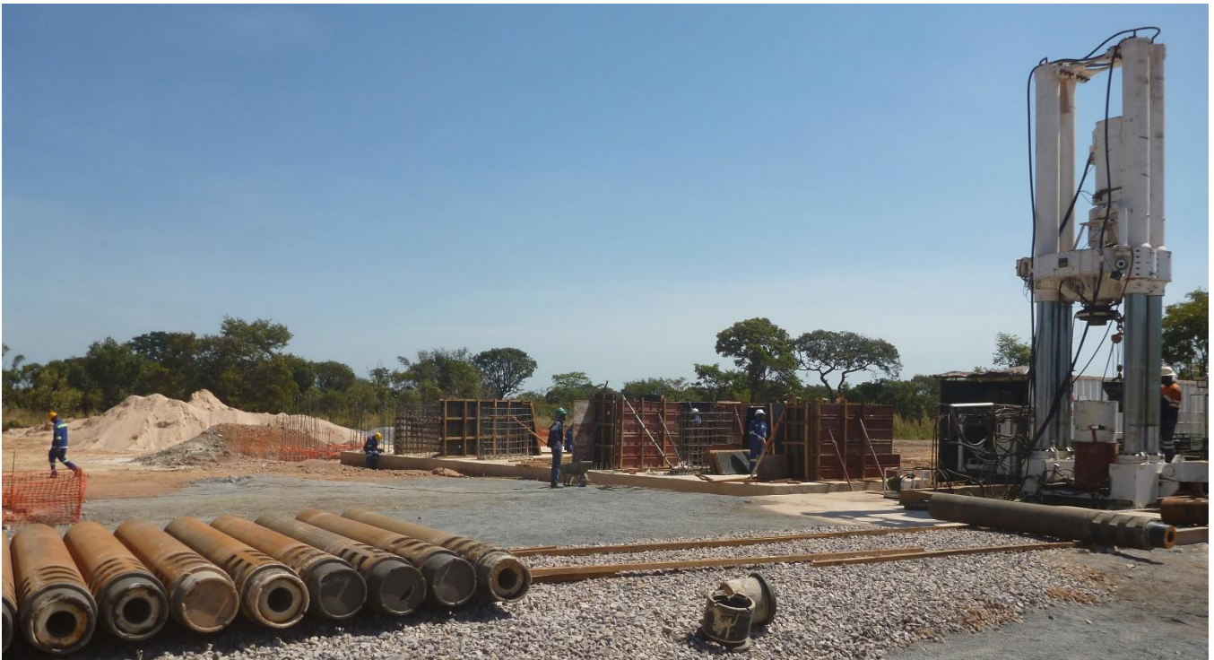
图 13 : 在一号通风矿井 (右) 运作的天井钻孔机，旁为正在建设中的混凝土地基以支撑大型的通风机。
