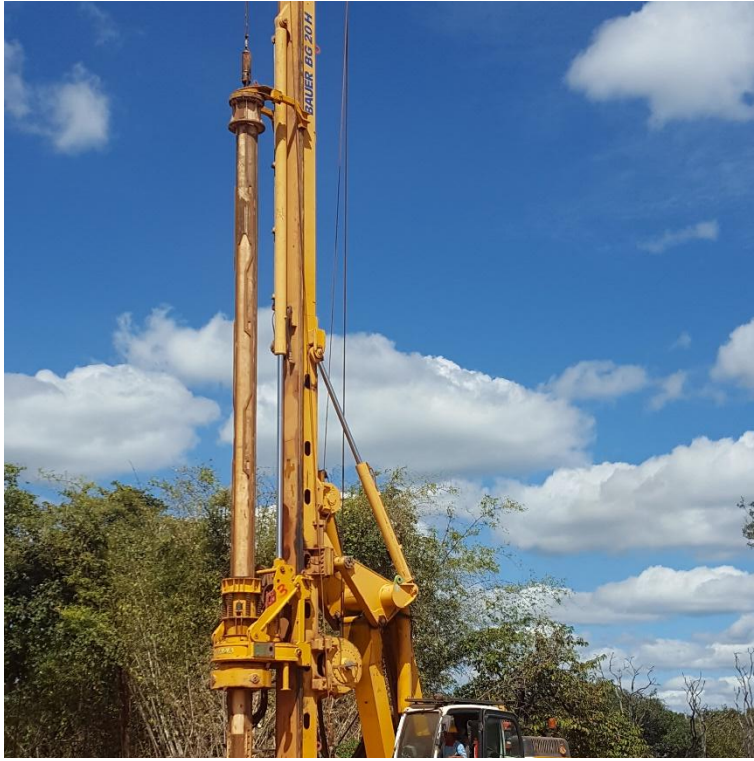
图 14：为二号通风矿井进行导孔钻孔工程。
