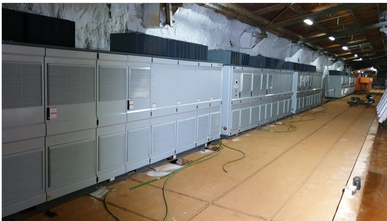
Kipushi 地下矿场已安装新的配电板。
