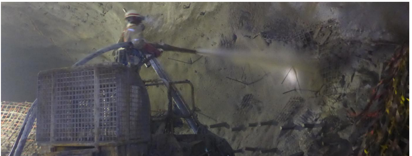
在一号矿井 850 米水平的矿井站，为 6.5 米长的固定螺栓和钢线网喷射混凝土以巩固井口。
