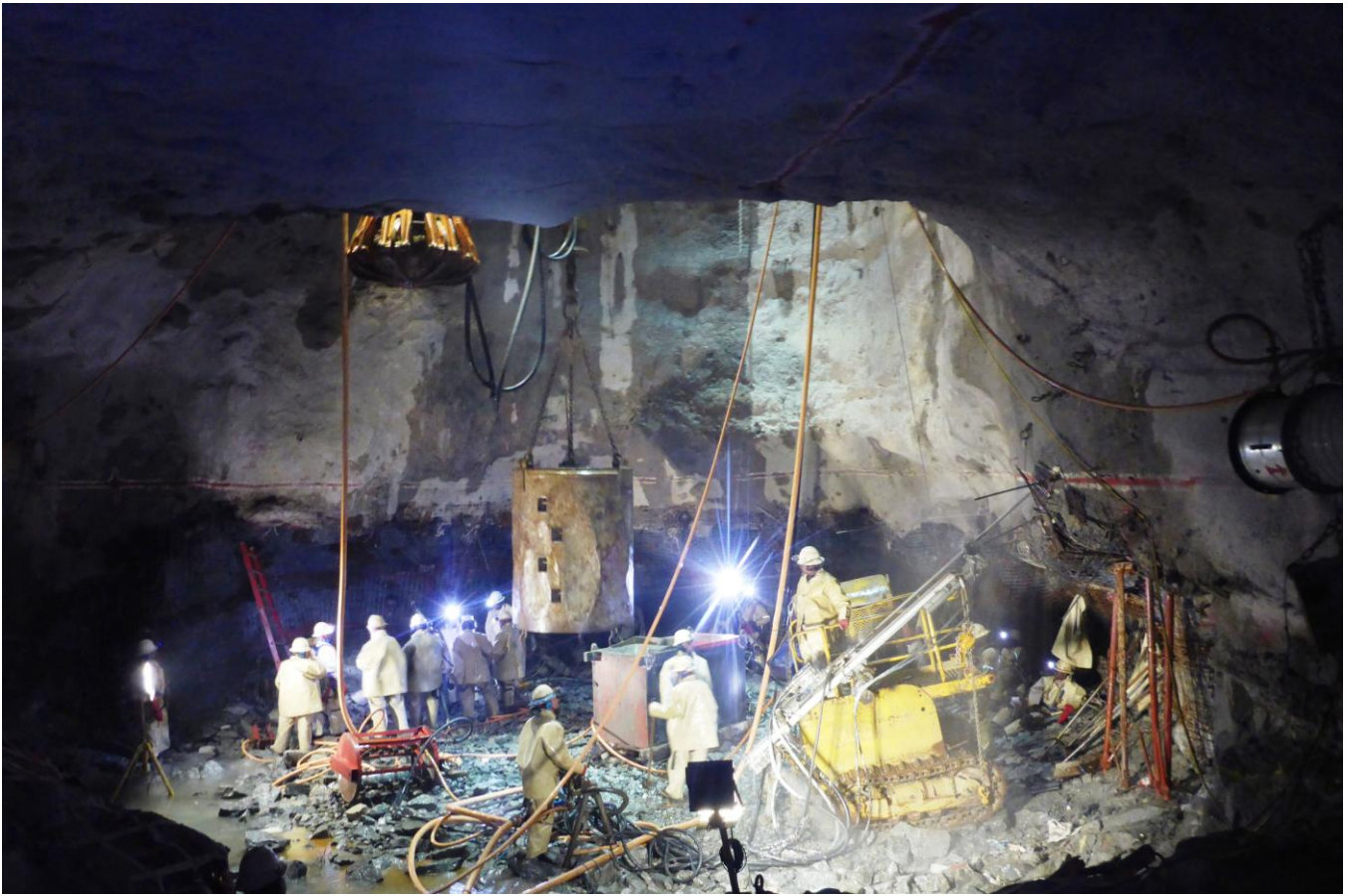
在一号矿井 850 米水平的矿井站，为 6.5 米长的固定螺栓和钢线网喷射混凝土以巩固井口。
