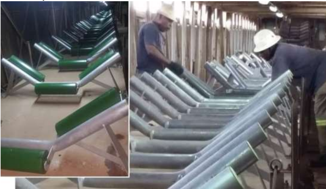
图 12 : Kipushi 改善工程其中一部分，在矿石输送带上安装新的滑轮和滚筒。
