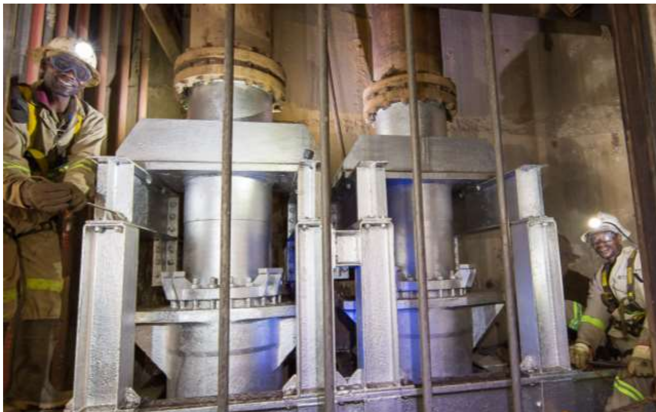
图 6：在 1,200 米水平的水泵站加强五号矿井的水泵支柱。
