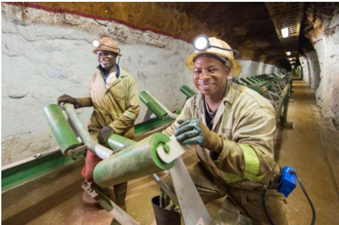
图5：基建升级计划的其中一部分，于1,150米水平的矿石输送带安装新的滚筒。
