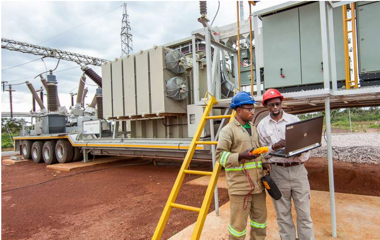
图 9：Kamoa-Kakula 项目团队成员正在建设 11 千伏流动变电站。变电站连接刚果国家电网，而电网目前为矿场规划的斜坡道供电。
