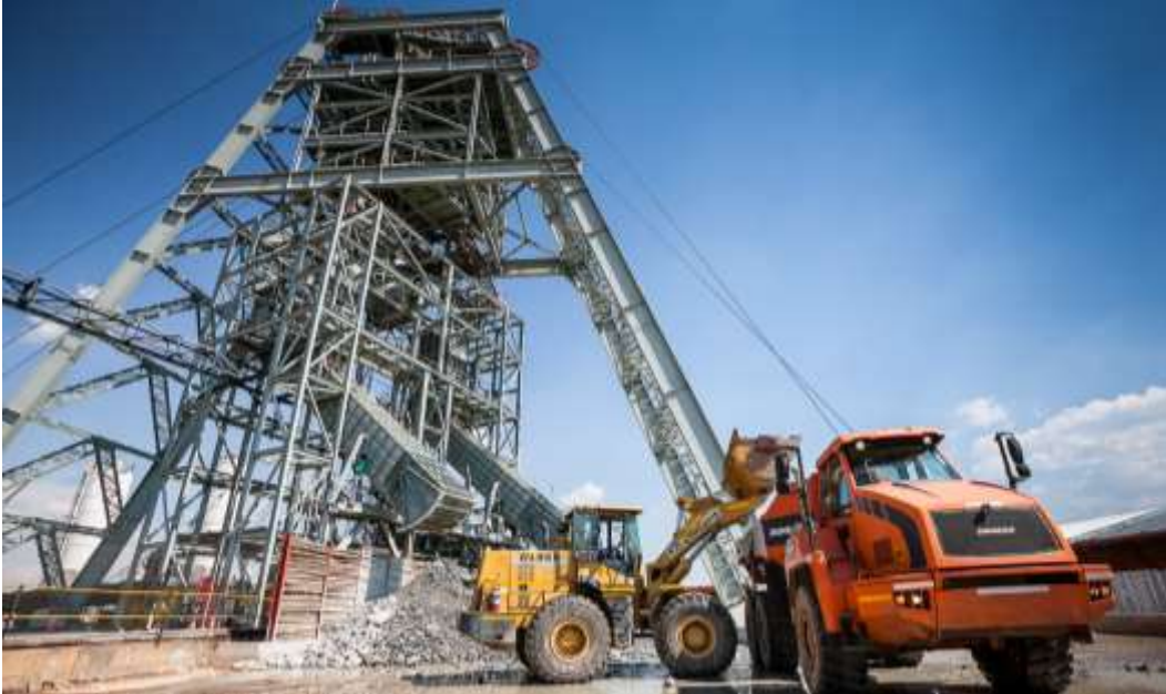
图 1：Platreef 项目的一号矿井井架，显示从凿井操作移走挖掘的岩石。
